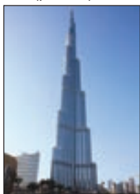
Рис. 57. Небоскреб в Дубае, высота 828 м, 163 этажа
