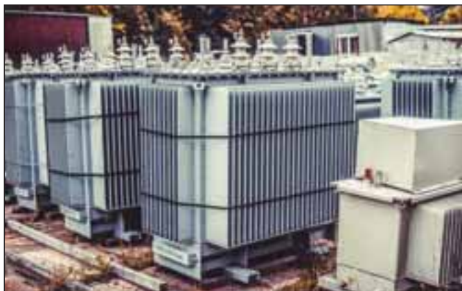
34-сүрәт. Кентау шәһиридә ясап чиқирилған күчлик трансформаторлар
