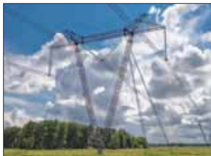
75-сүрәт. Лайиһәләнгән күчиниши 1150 кВ «Экибастуз – Көкшетау» электр йәткүзгүчи линиялири
