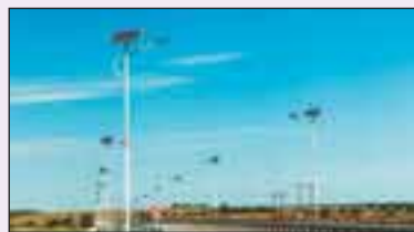
Күн батареялири бар коча фонарьлири
