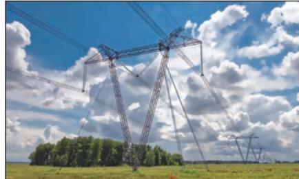
*Рис. 45. ЛЭП «Екибастуз – Кокшетау» с проектным напряжением 1150 кВ*
