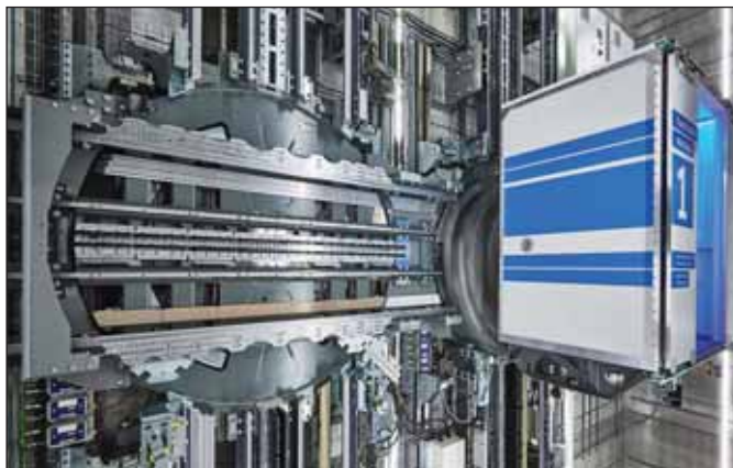
192-сүрәт. MULTI лифтиниң рельслари вә кабининиң қийлишишидики айланма диск
