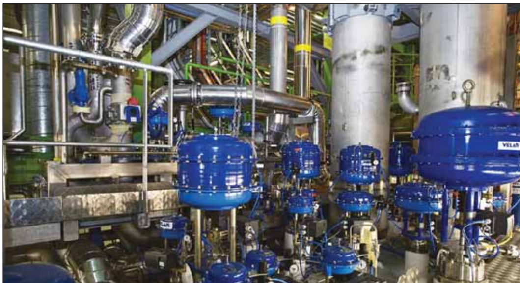
187-сүрәт. УАС криогенлик системисиниң суюк гелий үчүн һаҗәт -271,25^{\circ}\text{C} температурини тутуп туридиган бөлүги
